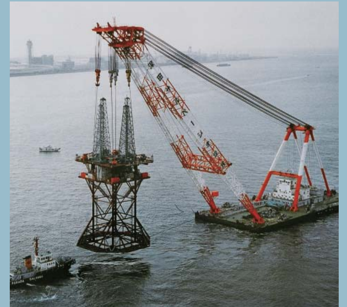
Ⅱ期工事 大型計測機 設置作業
