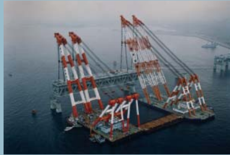
トラス橋相吊架設工事
