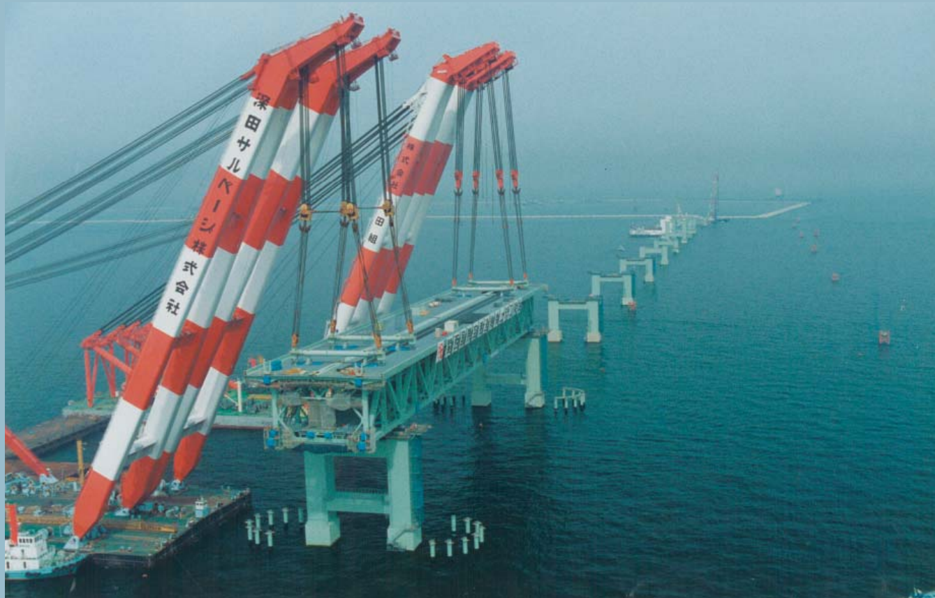
トラス橋相吊架設工事
