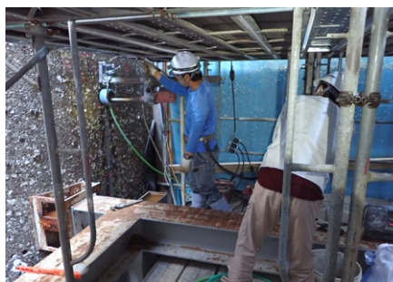
7 ボックス内施工状況
