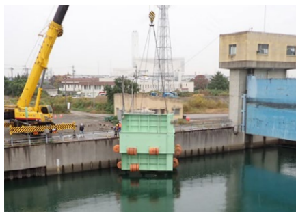
4 大型重機により着水
