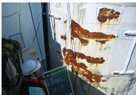
4 補修前現地確認
