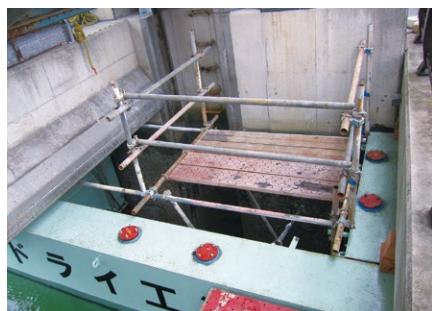
8 足場組み立て
