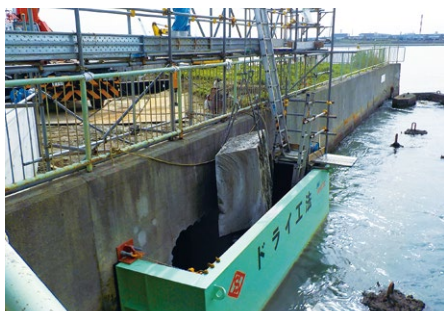
7 コンクリート壁引き抜き(海側)
