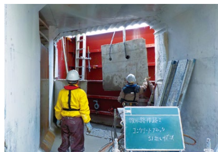
6 コンクリート壁引き抜き(陸側)
