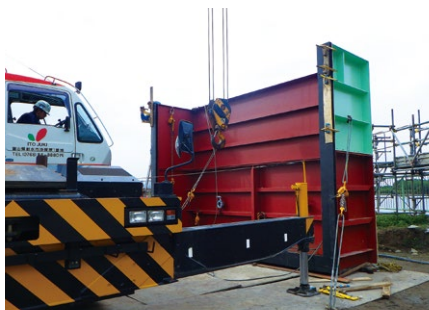
2 組み立て、特殊パッキン張り付け
