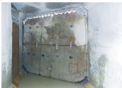
5 陸上部からコンクリート壁破孔
