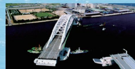
2000年(平成12年) 夢舞大橋(浮体式旋回可動橋) 曳航・係留架設工事
