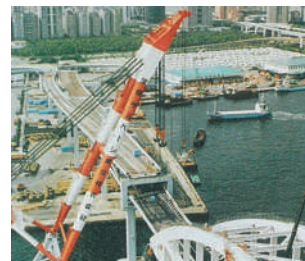
1995年(平成7年) 阪神淡路大震災 復旧・復興工事
